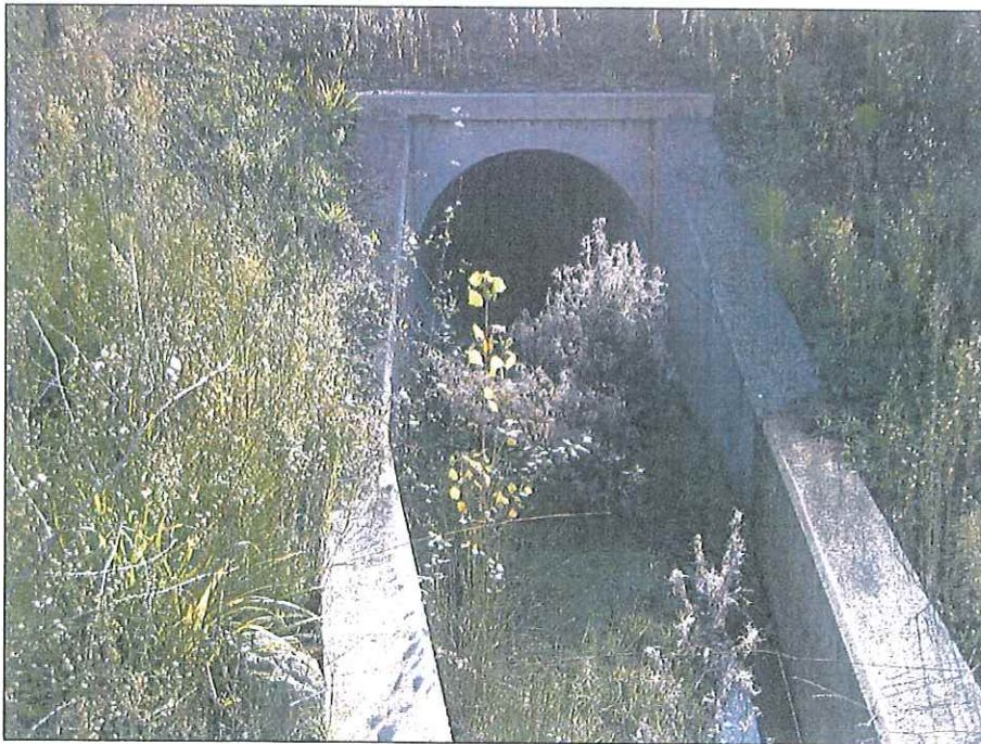
FOTO 14- ARROYO DE LA CANTERA. DESAGÜE.
