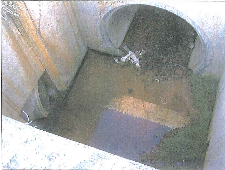
FOTO 15- ARQUETA DEL DESAGÜE DE LA CANTERA.
